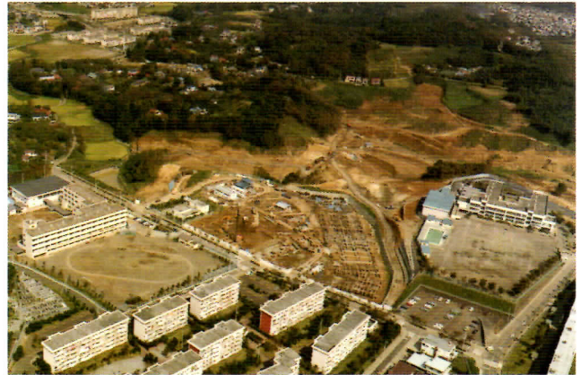
校舎基礎工事
